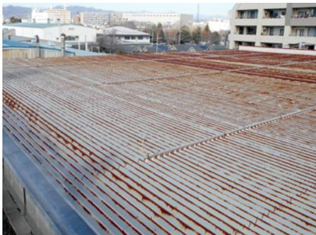
①屋根全体がサビってしまった倉庫の屋上。一部では亀裂などが原因による雨漏りも見られる。
