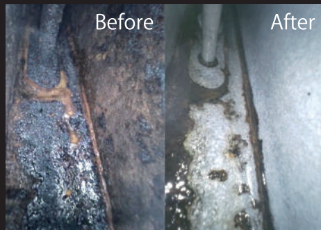
タンク内部のタール状の付着物はガソリンが腐って劣化した物。 漬け込み後(After)、サビはきれいに除去されています。
