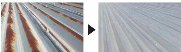
弊社シリコーン塗料ラバーロックの下塗りに使用、防錆＆雨漏りを防止。
