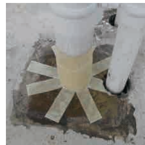
▲サビキラー PRO RSをコンクリート面に塗布。これによりBAN-ZI AID(紫外線硬化型補修シート)の密着を向上可能。
